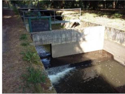
Mur transversal et ouverture avec vanne
