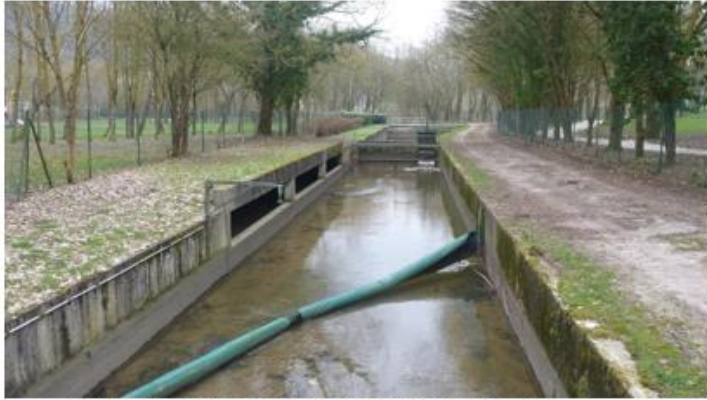
Bassin amont et canal de décharge en rive gauche
