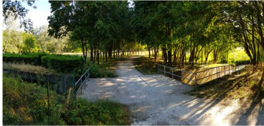
Pont aval entouré de végétation arboré constitué essentiellement de fresnes
